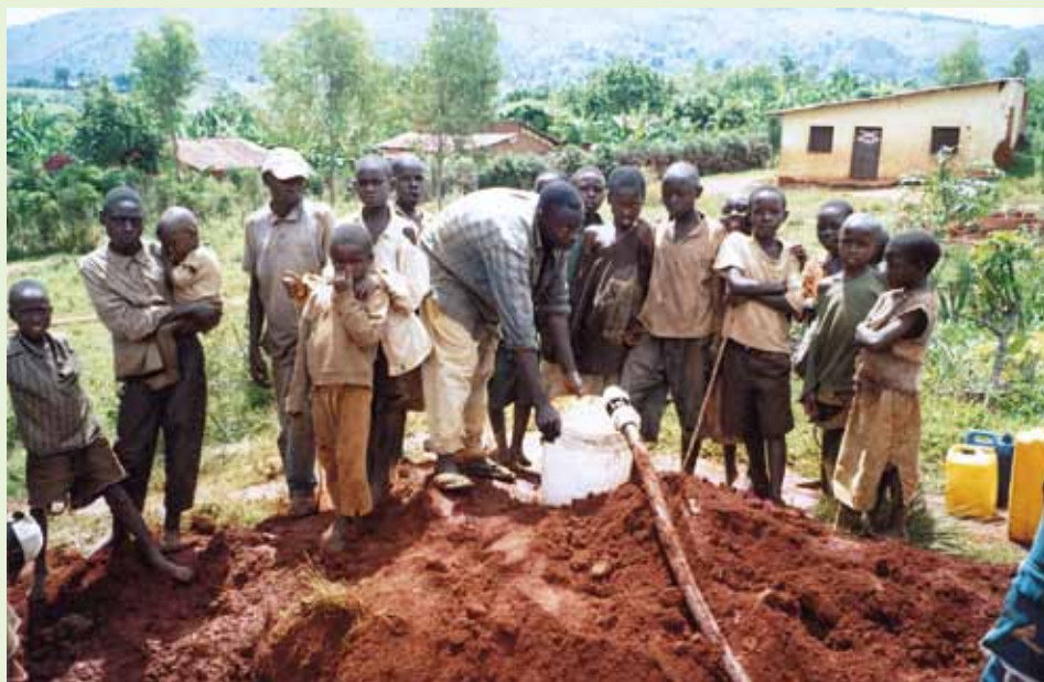
Lavori per l'acquedotto a Mutwenzi
